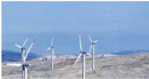
Sustav vjetroelektrana na paškom brdu Ravne.
